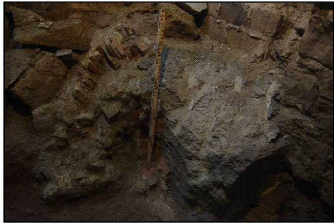
Perfil de la volta de la fossa sèptica un cop desmuntada la part afectada
