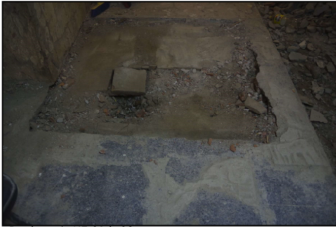
Paviments UE-01 i 02
