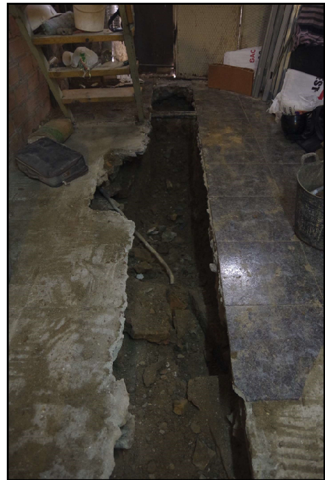
Rasa del pas del clavegueró, un cop retirat el pas existent
